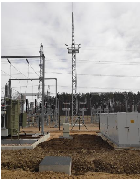
1.6.10. attēls. Augstsprieguma apakšstacija būvniecības procesā – Tārgales projekts, 2022 (foto: SIA Enviroprojekts)
