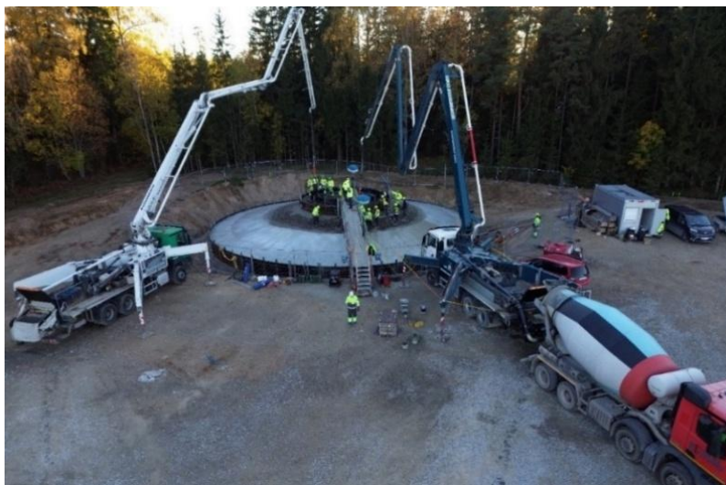
1.6.3. attēls. VES būvniecība Telšos (foto: LVP, 2024)
