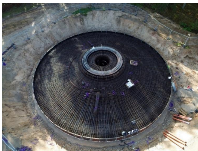
1.6.7. attēls. VES pamatu konstrukcijas metāla konstrukciju daļa darba procesā Telšos (foto: LVP, 2024)
