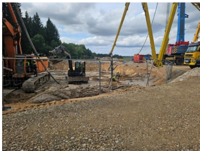
1.6.6. attēls. VES būvlaukuma pamatne sagatavošanas procesā Telšos (foto: LVP, 2024)
