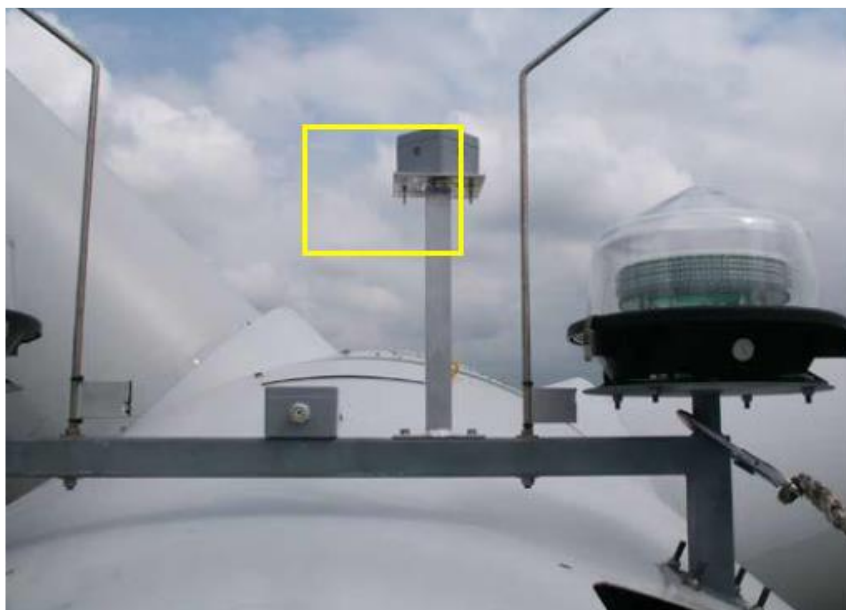
4.3.6. attēls. Virs VES gondolas uzstādīts gaismas sensors mirgošanas efekta novērsšanai (avots: SIA "Ventpils Wind" VES būvniecības Tārgales pagastā, Ventpils novadā, IVN, SIA "Vides eksperti", 2022)
