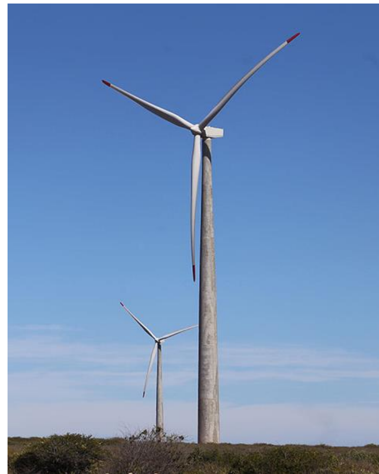
1 Attēlā turbīnas ar betona torni.
