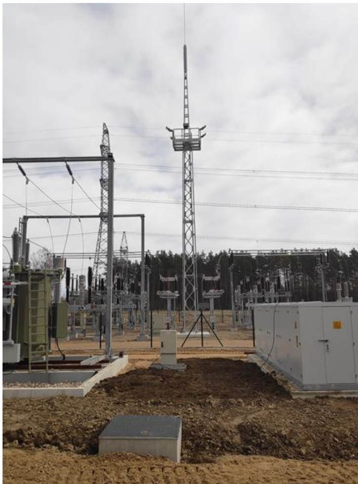
4.3.11. attēls. Augstsprieguma apakšstacija būvniecības procesā – Tārgales projekts, 2022 (foto: Enviroprojekts )
