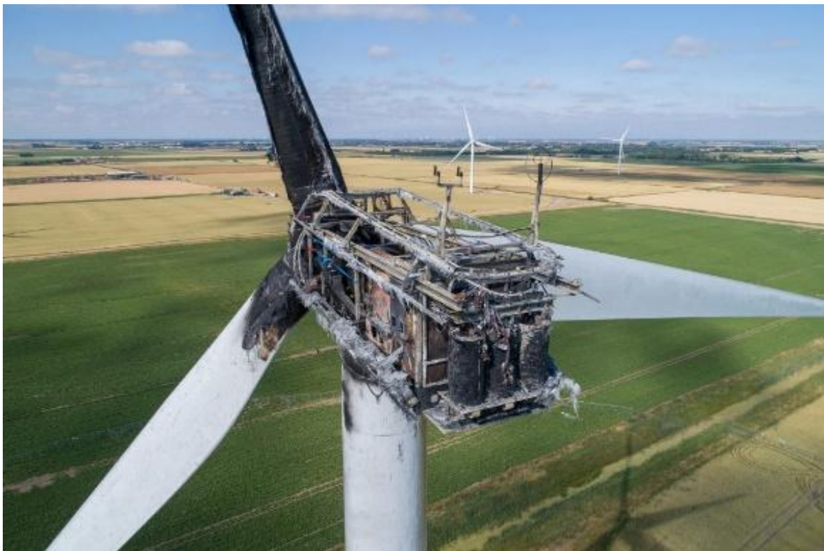
5.3.9. attēls. VES bojājumi, ko izraisījis ugunsgrēks. 80
