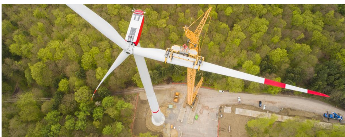
4.3.3. attēls. VES montāžas un apkopes laukums (piemērs – VESTAS 5,6 MW)
