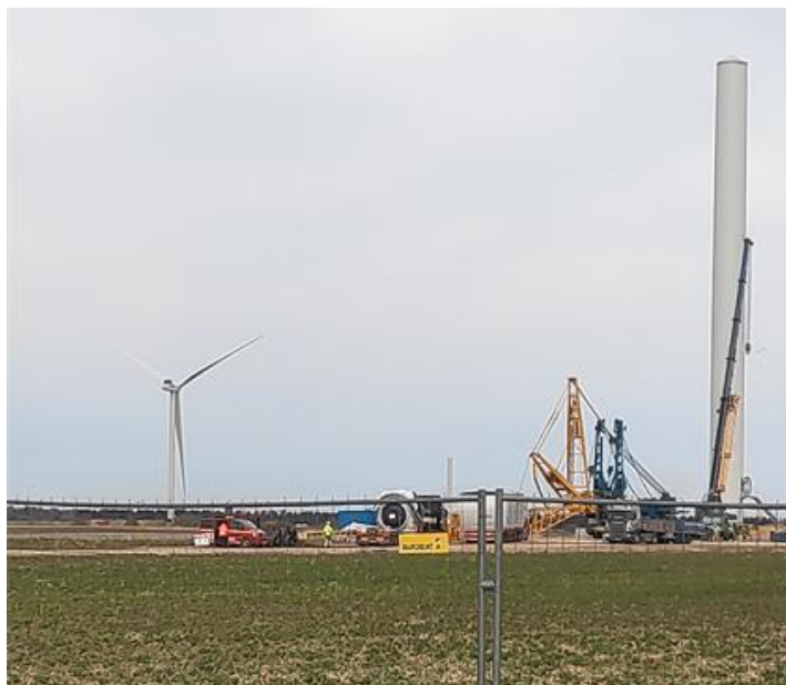
4.3.10. attēls. VES montāžas procesā Latvijā: Tārgales projekts, 2022 (foto: Enviroprojekts)
