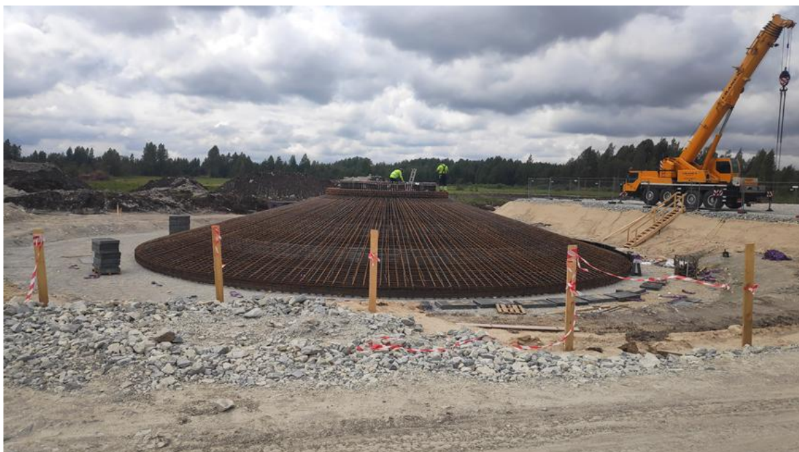
4.3.8. attēls. VES pamatu konstrukcijas metāla konstrukciju daļa darba procesā (foto: Enviroprojekts, Igaunijā, 2023)
