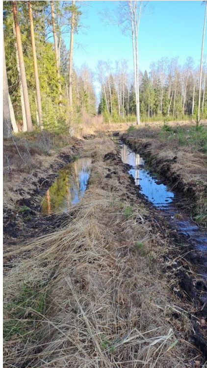
D1–3.attēls Pievedceļš VES D1 (ceļa galā)
