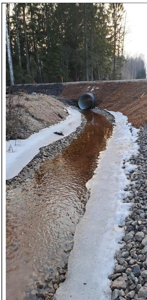
Z13-3 attēls. Skats uz susinātājgrāvja MK 54113:26 caurteku
