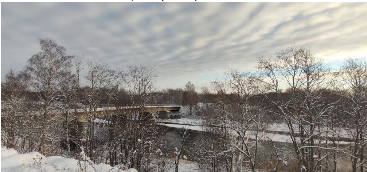
1. attēls. Skats uz Annasmuižas tiltu DA virzienā no skatu/atpūtas vietas upes labajā krastā.
