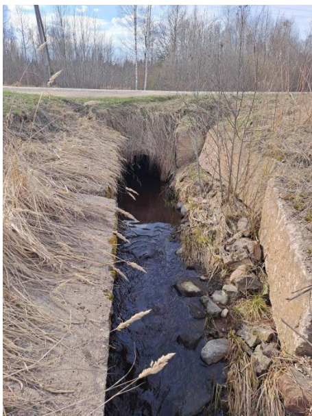
11.attēls. Novadgrāvja ŪSIK kods 41614:K:3 caurteka zem P79 Vecbebri-Koknese (skats uz izplūdi, punkts 3)
