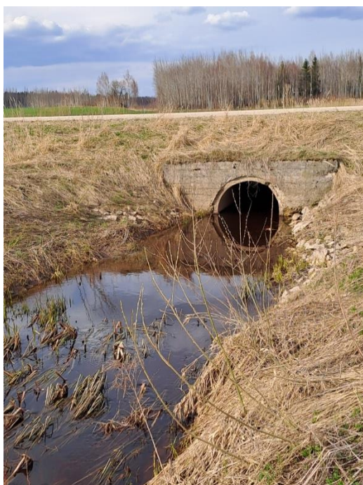
9.attēls. Bormaņu grāvja caurteka zem piebraucamā ceļa (skats uz izplūdi)
