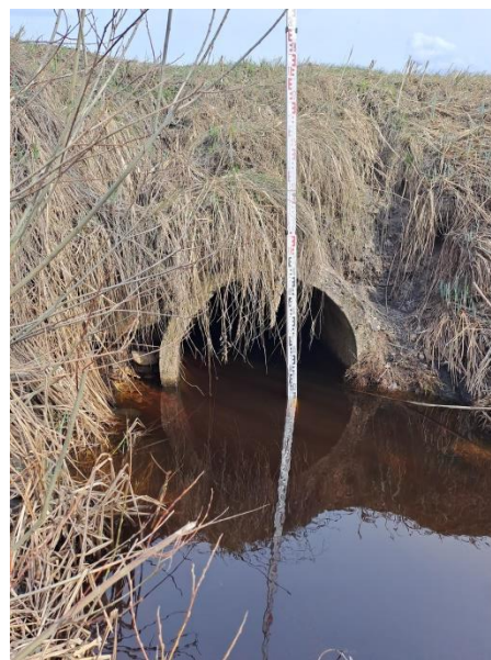
12.attēls. Novadgrāvja ŪSIK kods 41614:K:3 caurteka zem P79 Vecbebri-Koknese (skats uz ieplūdi, punkts 4)
