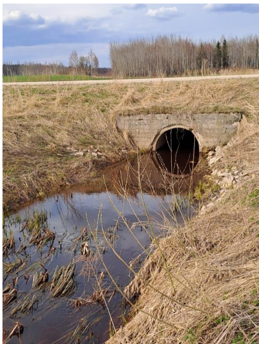
11.attēls. Bormaņu grāvja caurteka zem piebraucamā ceļa (skats uz izplūdi)
