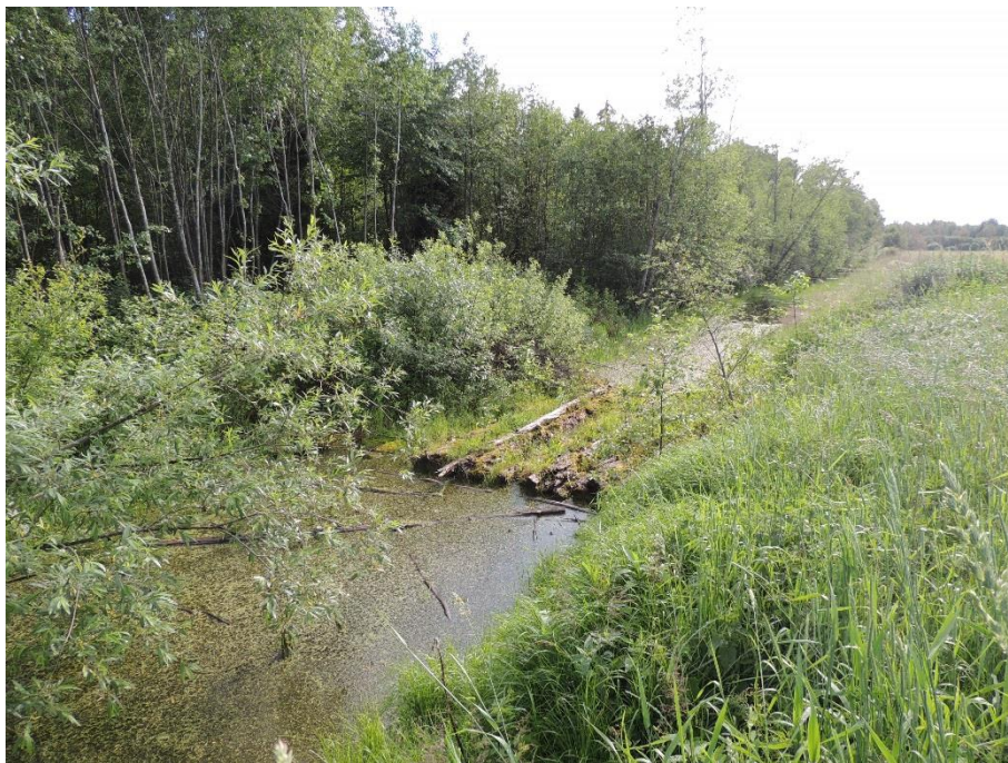
No baļķiem veidota pārbrauktuve uz Senču grāvja 3,1 km attālumā no ietekas Bebrupē (skats uz rietumiem)
