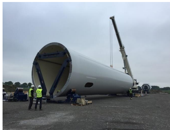
1.3. attēls. Vairāku segmentu VES mastā posms (Vestas LDST; http://terralwind.com )
