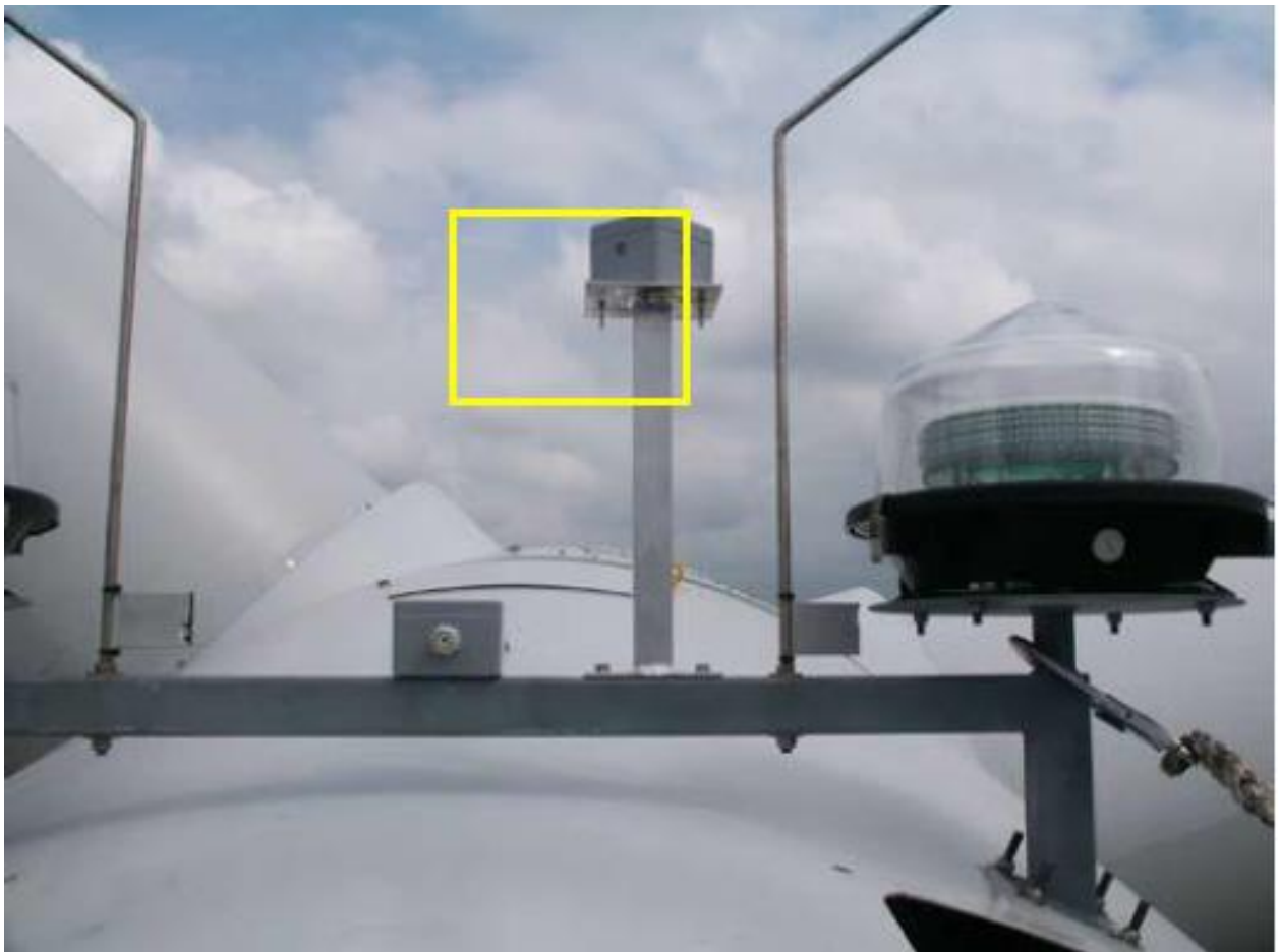
5.4. attēls. Virs VES gondolas uzstādīts gaismas sensors ēnas mirgošanas novēršanai (avots: SIA “Ventspils Wind” vēja elektrostaciju būvniecības Tārgales pagastā, Ventspils novadā, ietekmes uz vidi novērtējums, SIA “Vides eksperti”, 2022)
