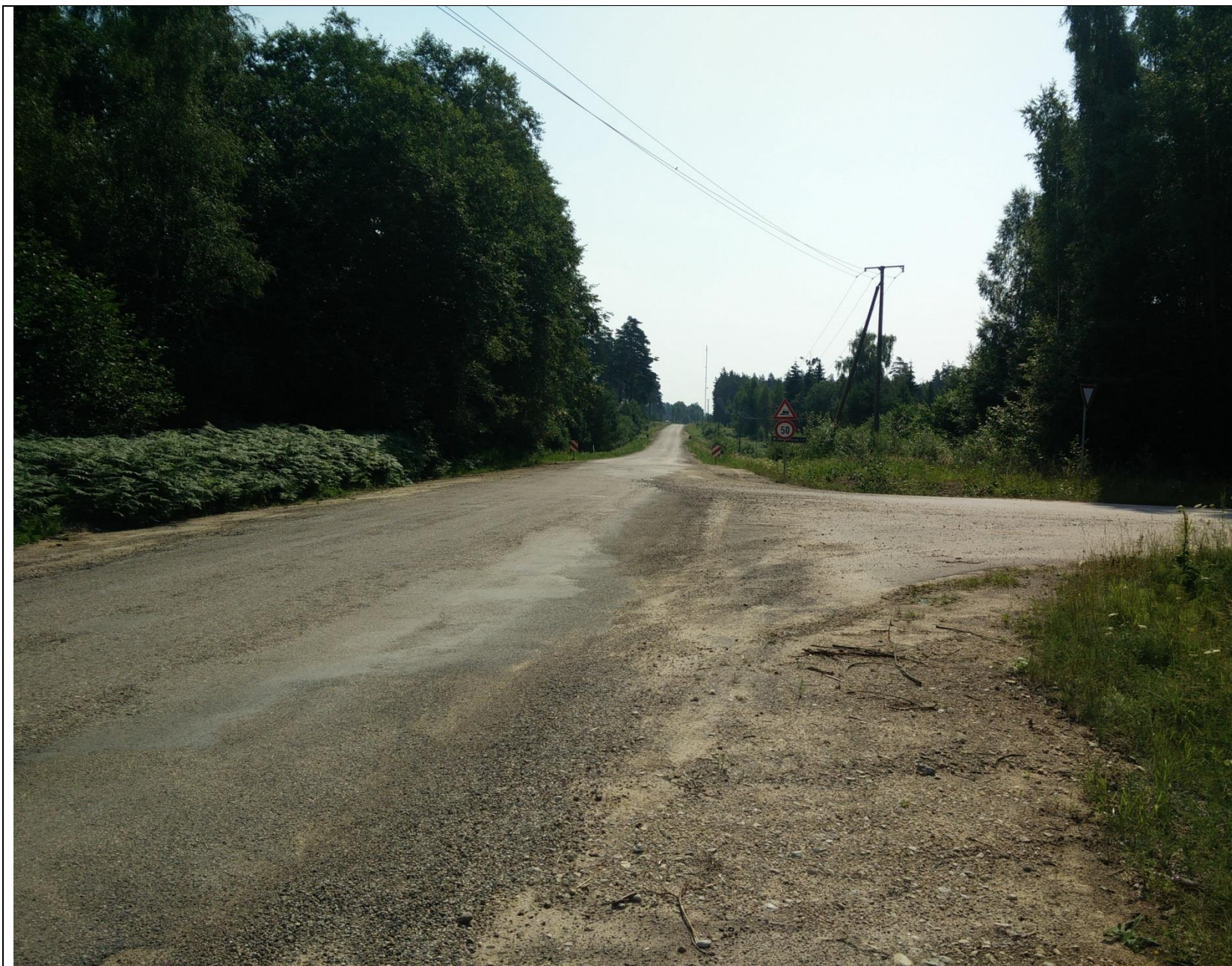
2.9. attēls. Vietējas nozīmes valsts autoceļš V1284 Renda-Āpas Jāšu ceļa 2 pieslēguma (no labās puses) vietā: skats Rendas virzienā pār Dzelzāmurupes tiltu.
