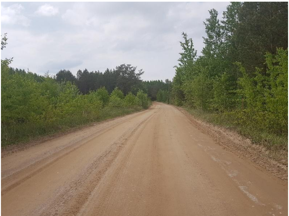
11.attēls. Skats uz paredzētās darbības Z daļā esošo pašvaldības ceļu. Kreisā pusē mežaudze starp ceļu un ieguves vietu
